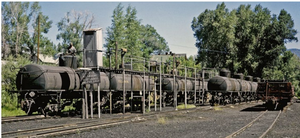
Das «Gramps Loading Rack» im Juli 1963 im Chama Yard. Rohöl wurde in einer kurzen Pipeline von einem nördlich von Chama gelegenen Feld hierhergepumpt, in Bahntankwagen verladen und bis 1964 über den Cumbres Pass zur Oriental Refinery in Alamosa transportiert. Die Enkel des Raffineriebesitzers nannten ihren Opa «Gramps».
