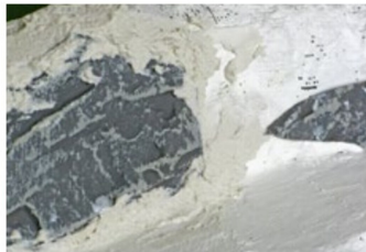
Das Füllmaterial verdeckt die Verbindungen der Heki-Folien.
