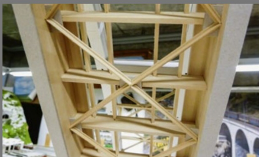
Unterkonstruktion der doppelspurigen Brücke.
