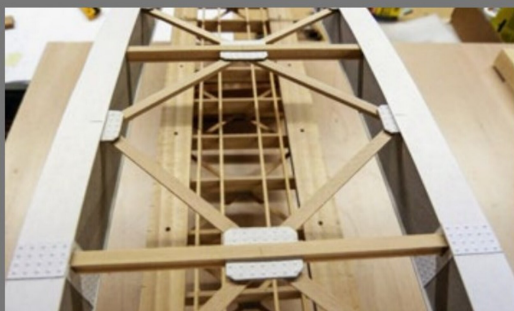
Blick vom oberen Windverband in die Fahrbahn.
