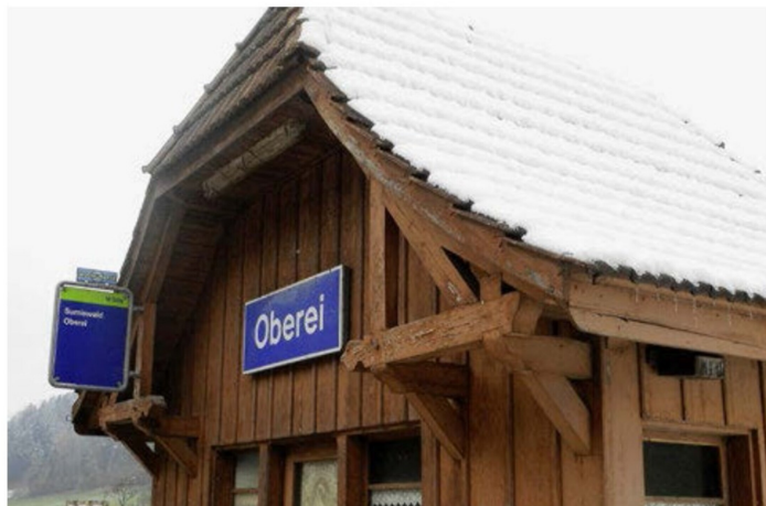
Die aufwendige Dachabstützung aus Holz.
