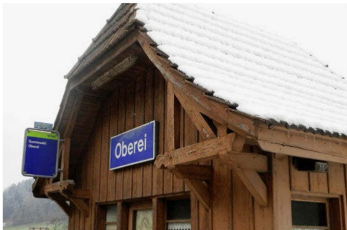
Die aufwendige Dachabstützung aus Holz.
