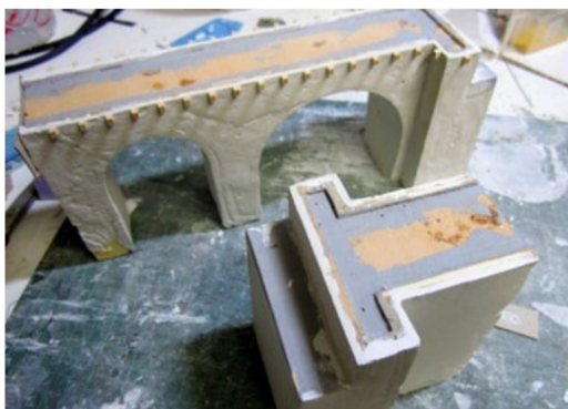
Für eine unregelmässige Steinstruktur wird die Aussenseite mit einem verdünntem Gips/Wasser/Weissleim-Gemisch betupft.
