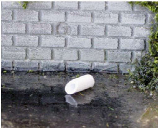
Das Stück Abflussrohr vor dem Einkleben in die Mauer. Man beachte die markierte Stelle in der Mauer. Dort wurde mit dem Rohr in die Mauer gedrückt.
