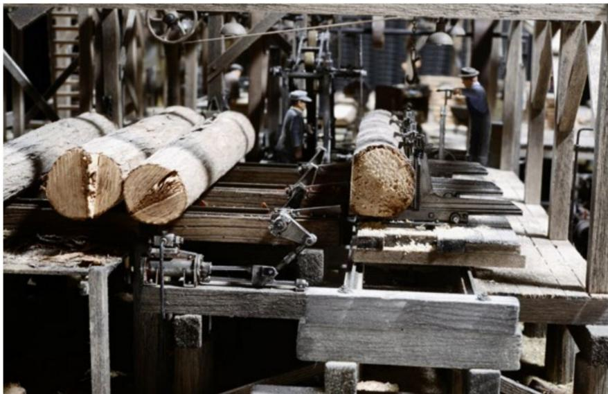
Selbst für starke Männer wären die Baustämme viel zu schwer. Deshalb wird für den Vorschub der Stämme Maschinenkraft eingesetzt. Die Bedienung erfolgt durch geschultes Personal.
