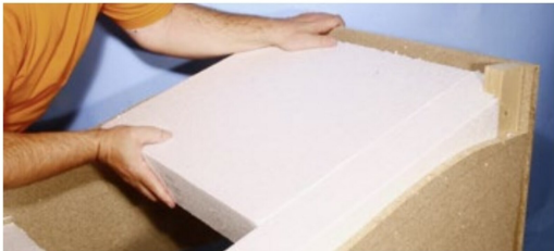
Die nächste Styropor-Platte wird in Hangneigung eingesetzt.
