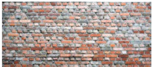
Blockverband aus Ziegelsteinen in ganz unterschiedlichen Farben.
