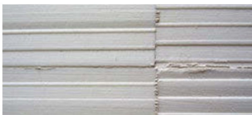
Zusammengesetzte Schalungsplatten (mit noch etwas breiten Bretterfugen).
