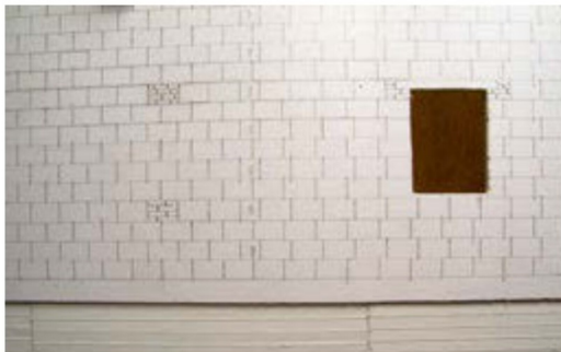
... sind Steine unterschiedlicher Formate vermauert.
