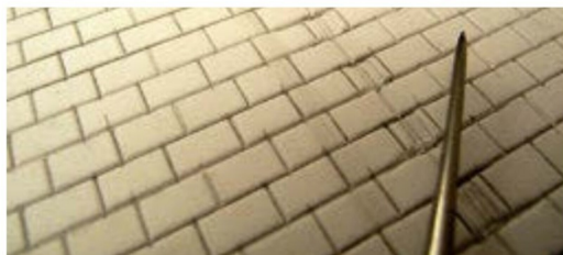
Hier das Mauerwerk mit einer eingebundenen Querwand.
