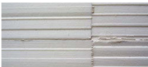
Zusammengesetzte Schalungsplatten (mit noch etwas breiten Bretterfugen).
