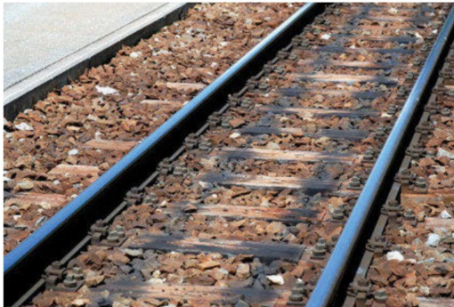
Rost und Schmierstoffe prägen massgeblich das Aussehen der Gleise.
