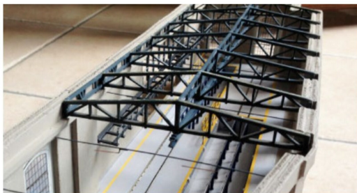
... die überzeugend wirkende Tragkonstruktion für das Hallendach.
