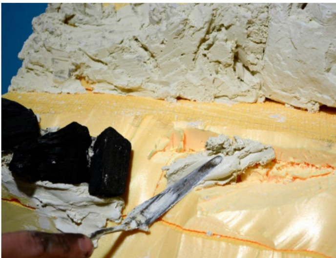
Schon sind wir bei Methode 3: Zur Befestigung der Kohle wird eine kleine Portion Gips aufgetragen.
