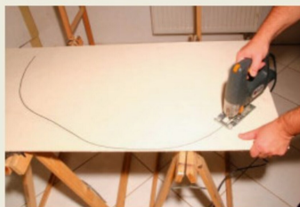
Aus Sperrholz wird die Abdeckplatte zugeschnitten.
